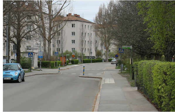
Figur 16. Passage över Tiundagatan vid Prästgårdsgatan. Vy åt nordväst. Hastighetssäkring med chican.
