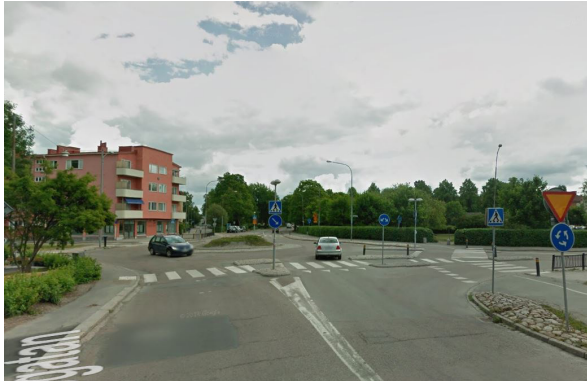
Figur 15. Cirkulationsplats Börjegatan/Ringgatan. Vy åt sydöst. Trafikmiljön med separata högersvängvält är svår att överblicka. Bild från google street view.
